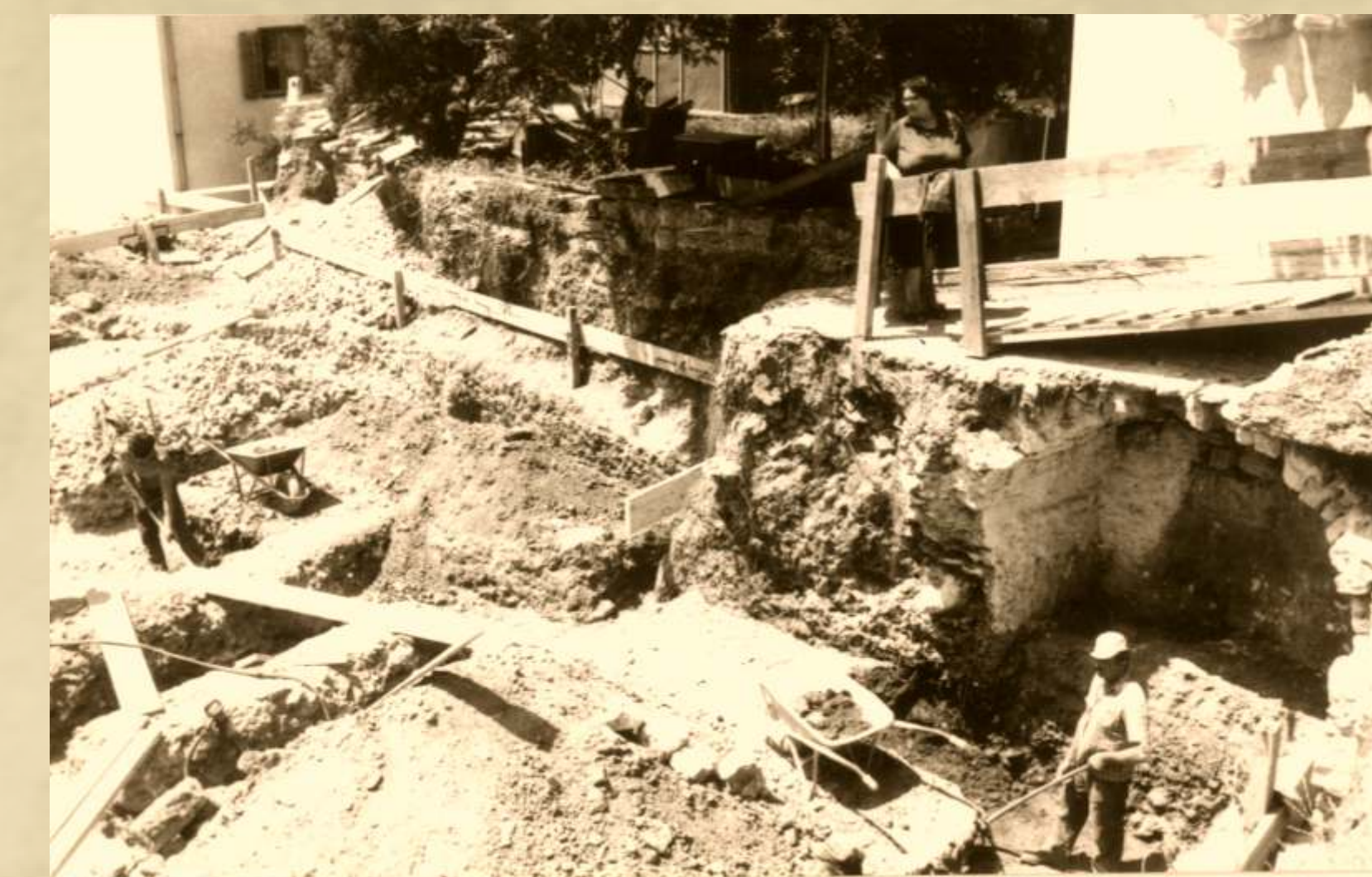
Široka kuntrada, radovi na novoj stambenoj zgradi, snimak od istoka u pozadini vrt i kuća Šojat, 1982. g.
